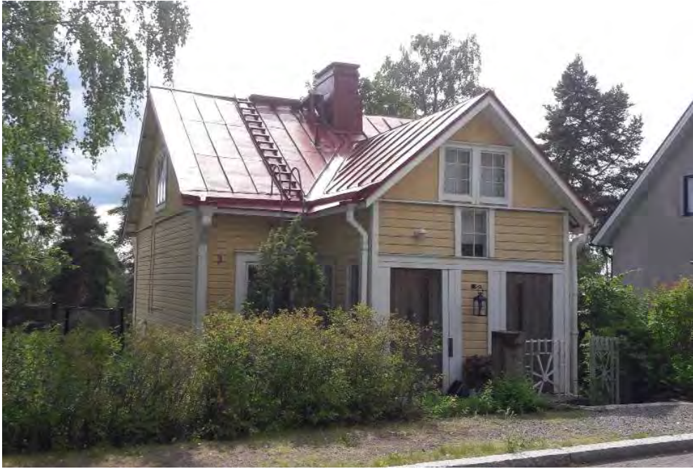
Risuharjankatu 3 talon rakennusvuodeksi on kirjattu 1927.
