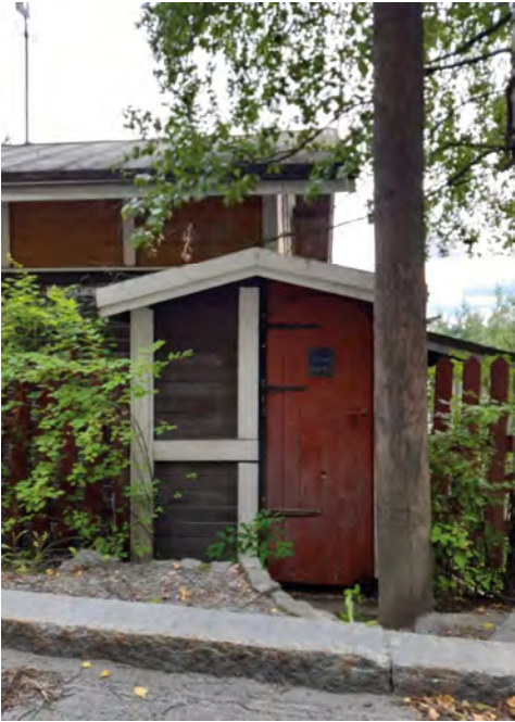
Teerentie 4 . Rakennuksen pääsisäänkäynti on Järvensivuntien puolella.
