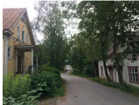
Sudenkatu 37 ja 46 välille muodostuu vanhaa maalaisraittia muistuttava miljö. Sudenkatu 46:n valkoinen rakennus on vuodelta 1934.
