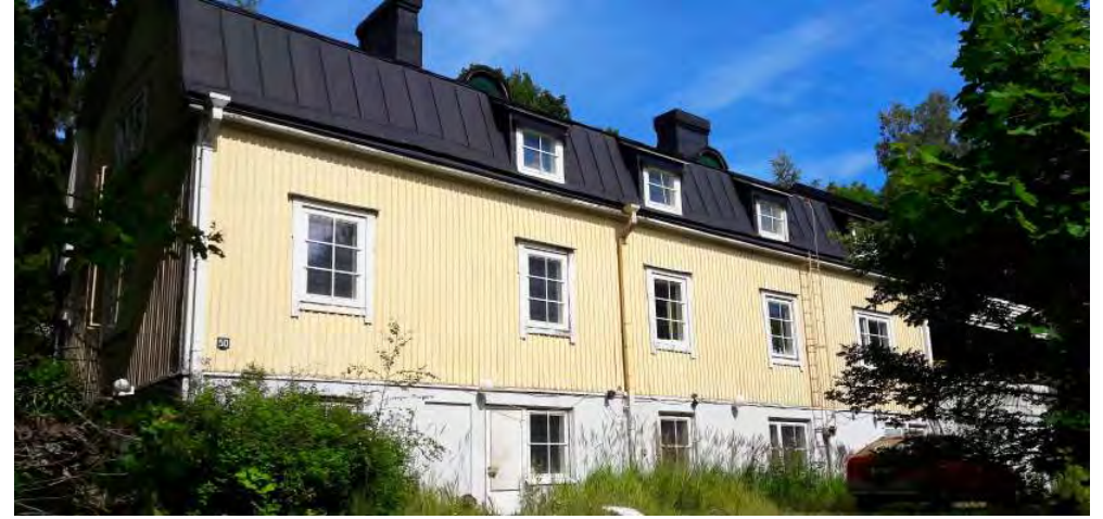
Osoitteessa Nokiantie 50 sijaitseva palstoittamalla syntynyt rakennus, jonka julkisivu on säilynyt ilman suuria muutoksia. Rakennusvuosi ei ole tiedossa.
