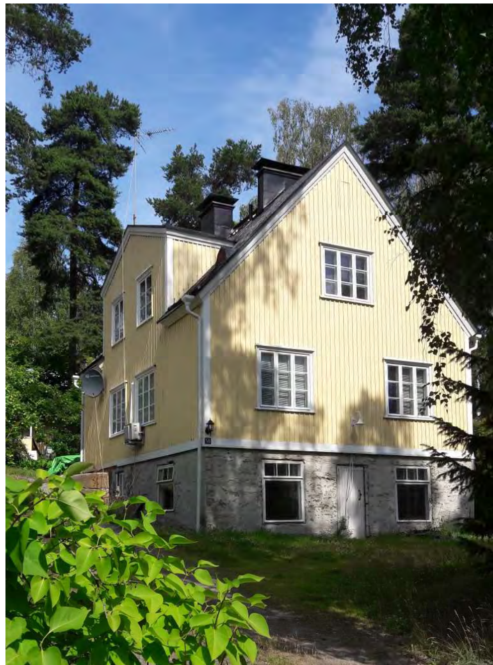
Nokiantie 60:n päärakennuksen tarkkaa rakennusvuotta ei ole tiedossa, koska alkuperäisiä piirustuksia ei ole rakennuslupa-arkistoissa. Rakennus on oletettavasti rakennettu ennen 1940-lukua.
