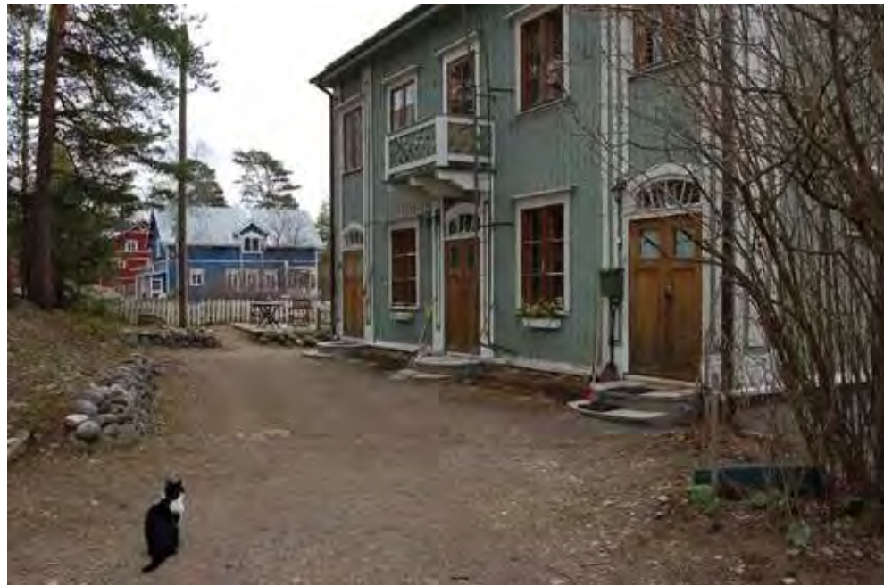
Entinen Kalimankujan linjaus ja kujan varren asuinrakennuksia. Kuva: Vapriikin kuva-arkisto. Minna Halonen. 2007.
