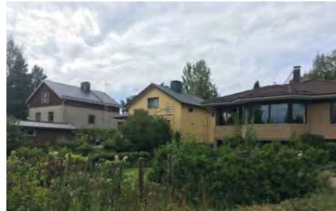
Rakennusaikakausien sekottuneisuutta Uudenkylänkadulla. Oikealla talo vuodelta 1988 ja sen vieressä kaksi 1950-luvun taloa.
